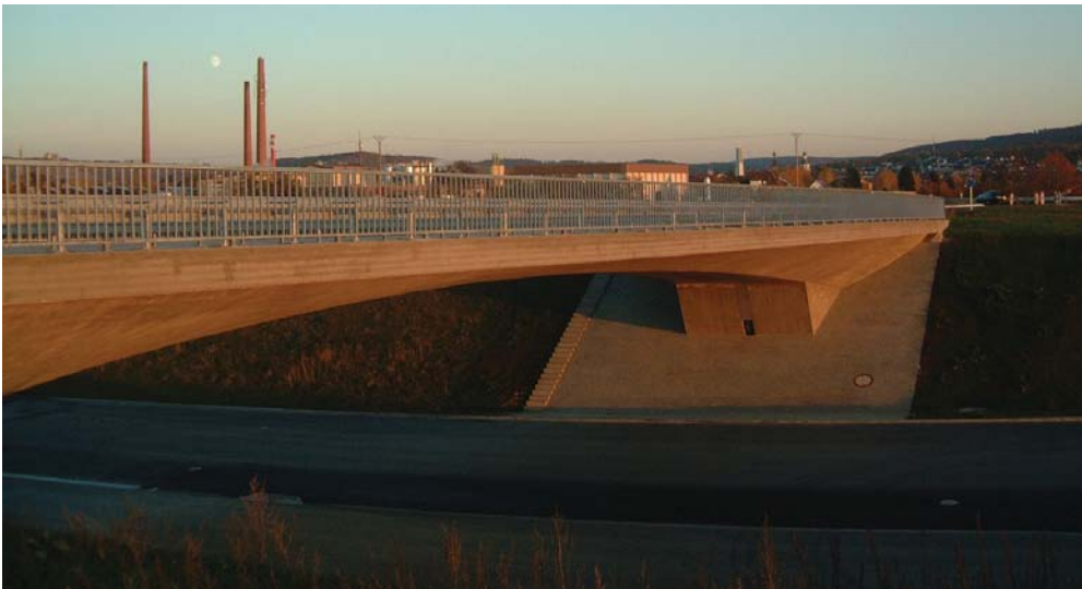
Bild 6. Bauwerk 5 im Zuge der neuen B14 bei Winnenden Fig. 6. Bridge No. 5 for the new highway B14 near Winnenden
