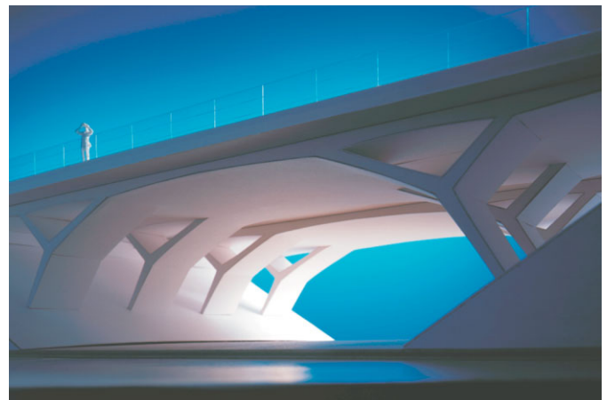
Bild 12. Bauwerk 1, Winnenden: Stabbogenbrücke, Modell M 1:100, Photo: Dietmar Strauß, Besigheim Fig. 12. Winnenden Bridge No. 1: deck-stiffened arch, model scale 1:100, photo: Dietmar Strauß, Besigheim
