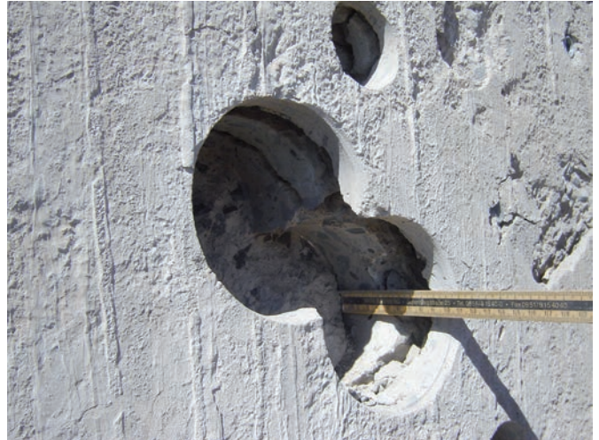
Bild 3 Kernbohrung im Bereich einer Abplatzung an einer vorgespannten Silowand Core boring at a delamination at a post-tensioned silo wall
