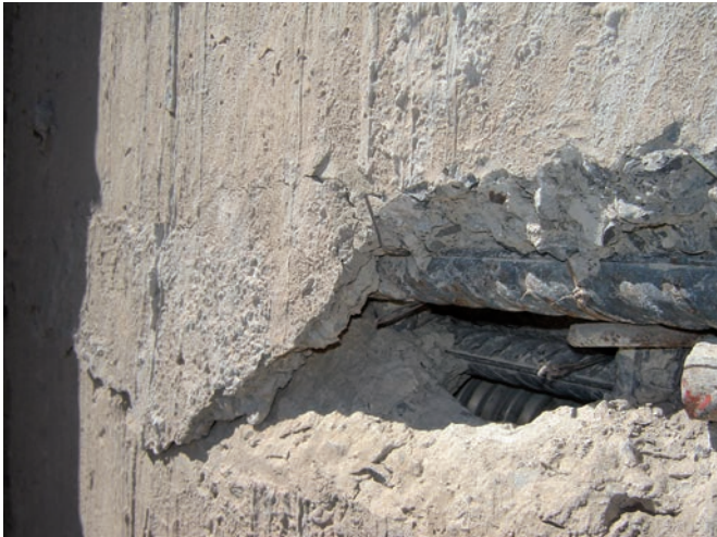
Bild 2 Unterer Rand einer Abplatzung mit Ringbewehrung und Hüllrohr eines Spannglieds Bottom edge of a delamination with ring reinforcement and tendon
