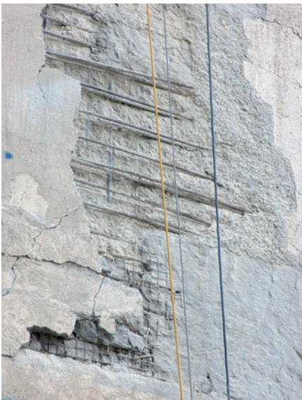
Bild 6 Delaminierung an einem Spannbetonsilo mit teilweise zerstörtem Verbund der Ringbewehrung (Foto: ALLVIA) Delamination at a post-tensioned silo wall, bond of ring reinforcement destroyed partly (Photo: ALLVIA)
