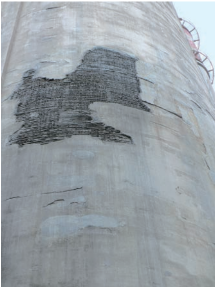
Bild 5 Großflächige Delaminierung an einem Spannbetonsilo (Foto: ALLVIA) Large delaminated area at a post-tensioned silo wall (Photo: ALLVIA)
