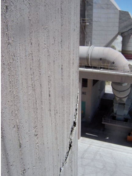
Bild 1 Blick von oben auf eine Abplatzung an einer vorgespannten Silowand View from top on a delamination at a post-tensioned silo wall
