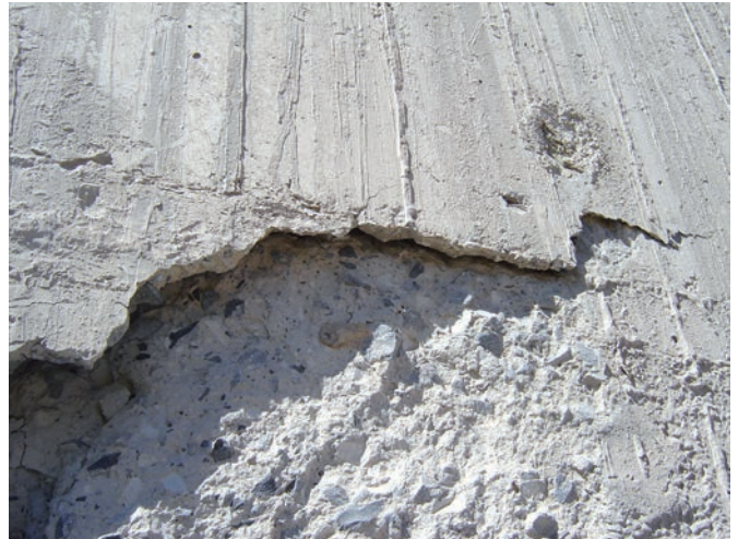
Bild 4 Papierdünn auslaufender Rand einer abgeplatzten Zone Wafer-thin edge of a delamination
